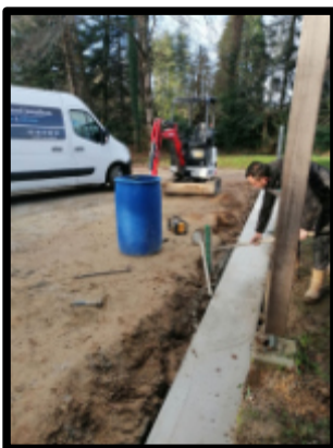
Pose de grillage et d'un portail coulissant au local technique.
