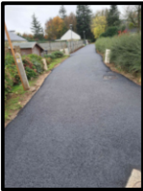
Travaux de voirie chemin de Kergroix - Kervenec - Presbytère - route de Kerganaouen.
