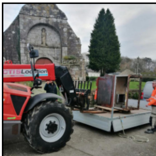
Dépollution de la chaufferie
