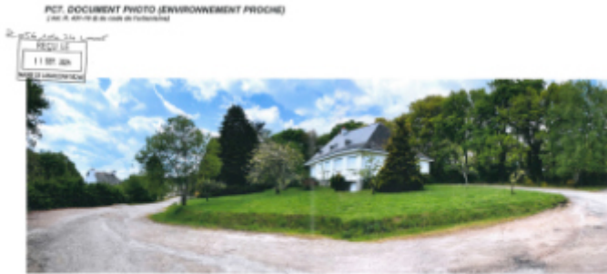
La maison JAOUEN va être déconstruite
