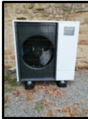
Remplacement des pompes à chaleur à l'école et à la médiathèque.
